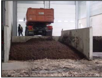
Figure 8 : Aire de dépotage des boues
