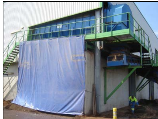
Figure 25 : Traitement des poussières en zone criblage
